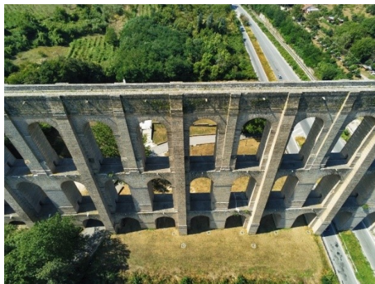
Particolare aereo dell'Acquedotto Carolino, Ponte della Valle di Maddaloni
