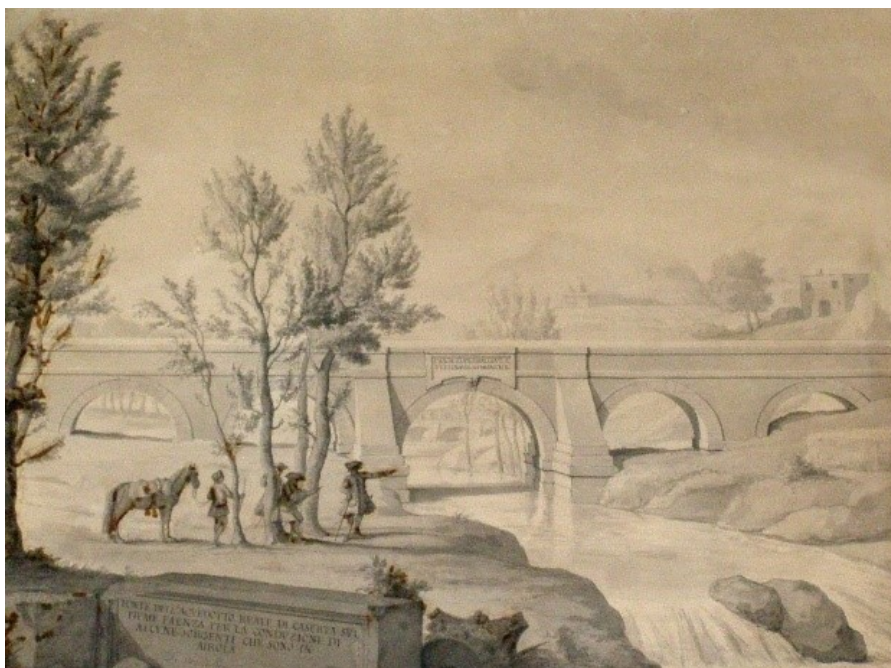
Acquedotto Carolino Ponte sul Faenza
